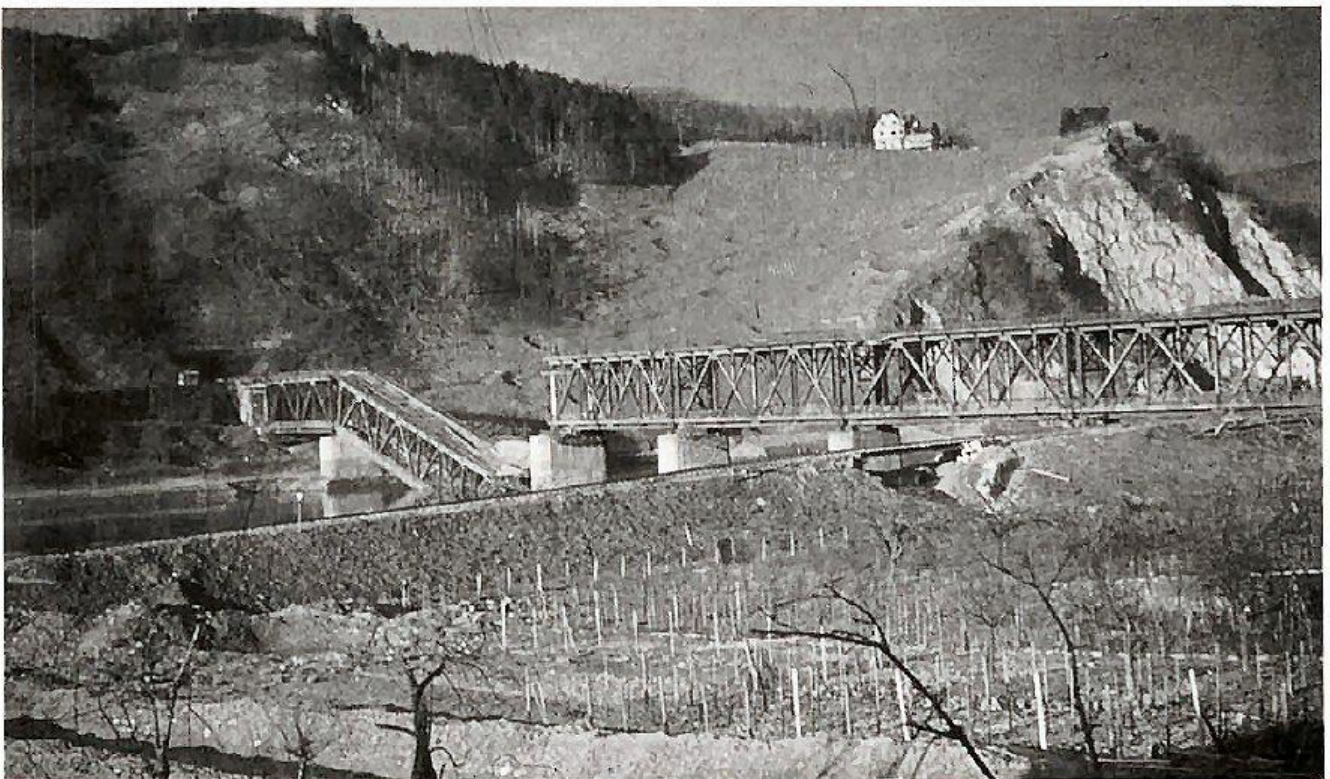
Der Hauptstrombogen der Brücke liegt im Wasser. Gut zu erkennen ist der Aussichtsturm (Richtziel) und das Hotel Waldfrieden sowie im Vordergrund der Damm der Moseltalbahn.
